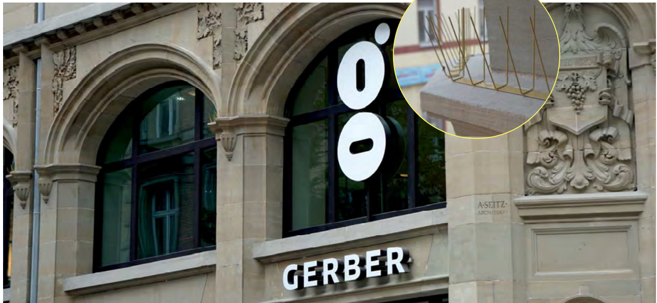
↑ Stuttgart / Das GERBER / TAS Edelstahl Rostfrei / gold-beige pulverbeschichtet
