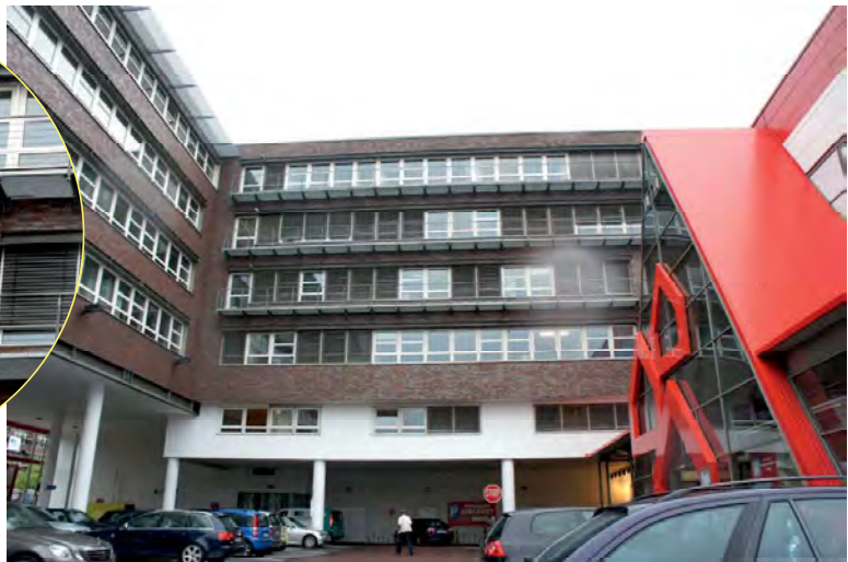
Hamburg Wandsbek / BAUHAUS / ↑ Balkone Vernetzung vertikal / Unauffälliges schwarzes monofiles Netz beeinträchtigt die Fassade nicht
