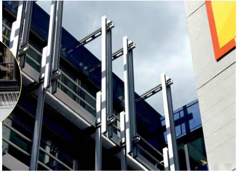
Stuttgart / Justizpalast / TAS Edelstahl Rostfrei / beige pulverbeschichtet ↓
